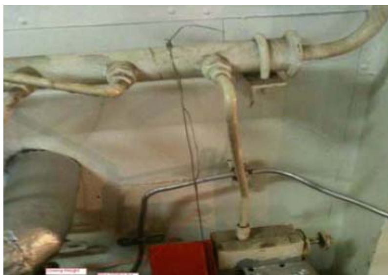
Hình 2: Van bị giữ ở trạng thái mở bằng dây kim loại
