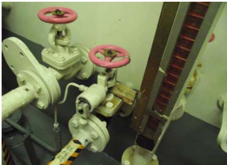
Hình 3: Van bị giữ ở trạng thái mở bằng nêm gỗ
