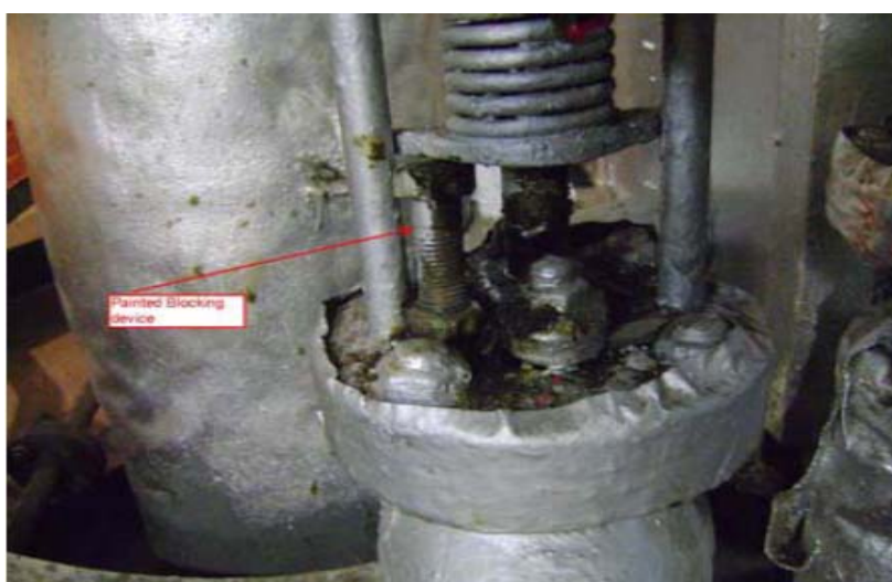
Hình 1: Van bị giữ ở trạng thái mở bằng bu lông
